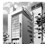
穴吹動物看護カレッジ (上天神に新校舎建設中)
